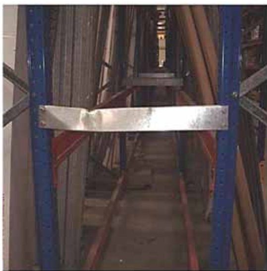
Los daños en las estanterías deben estar clasificados
