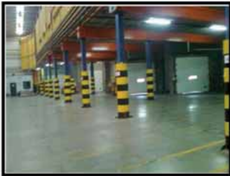
Señalización y protección adecuada de pilares
