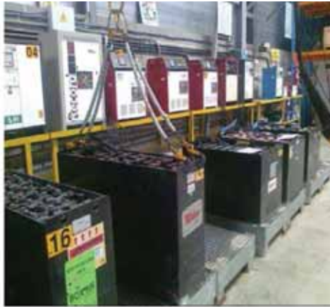
Sala de carga abierta de carretillas elevadoras
